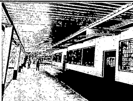
Foto 2: Techado de corredor
